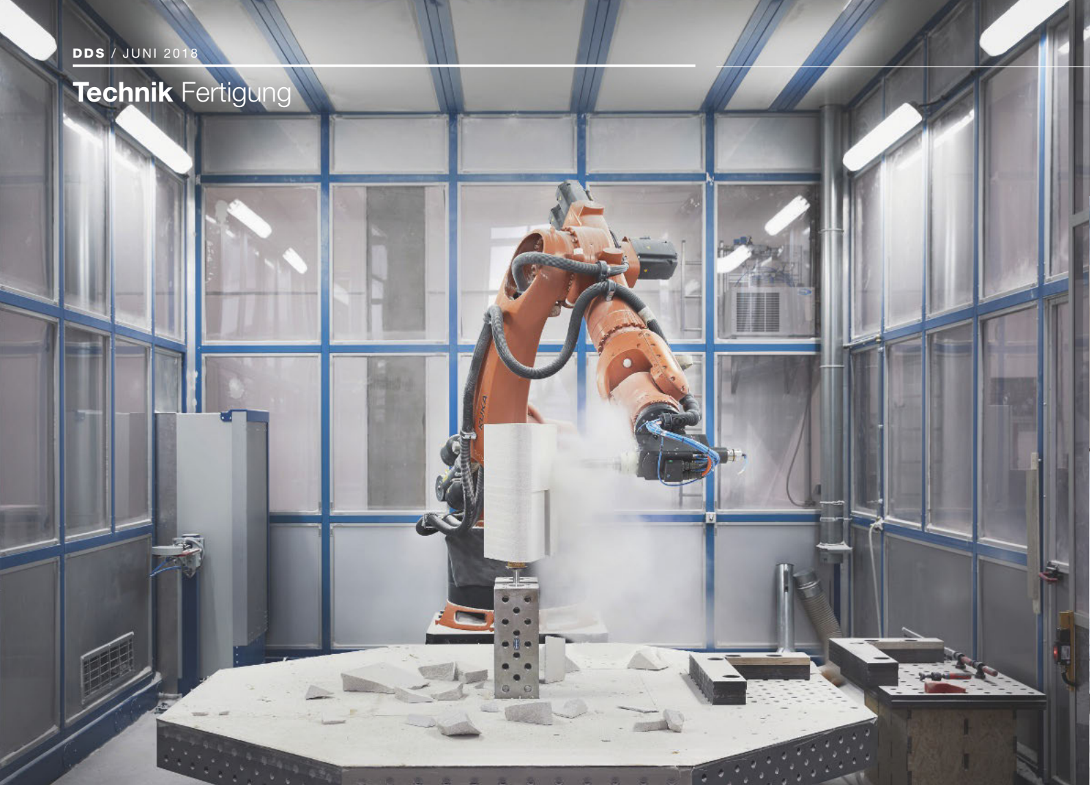
In der Schreinerei Ackermann fräst ein Roboter für den Ausbau des Penthauses über der Elbphilharmonie 3D-Objekte in Ytong-Blöcke ...
